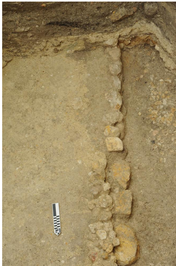
Figura 8.11. Estructura Ehb, barro atrás del muro y pedrín extendiendo el muro (D. Triadan).
