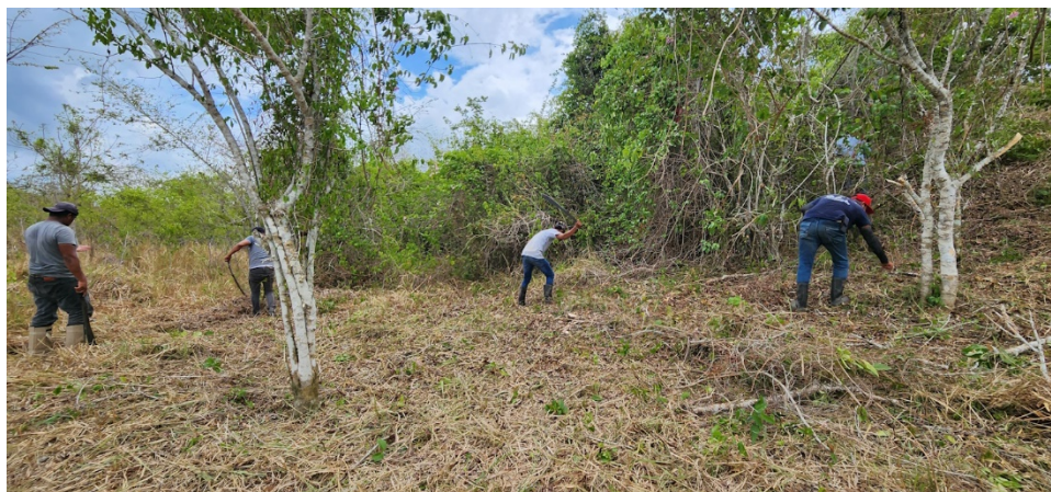
Figura 4.4. Desmonte y limpieza al SW de A1.
