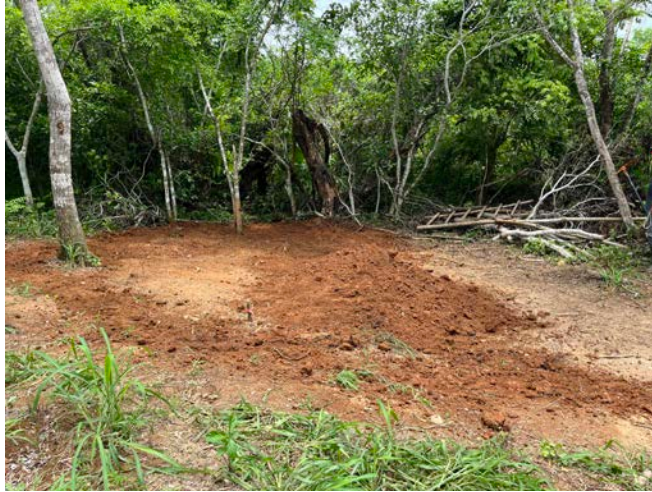
Figura 4.33. La Suboperación LO2A rellenada, desde la Estructura A4.
